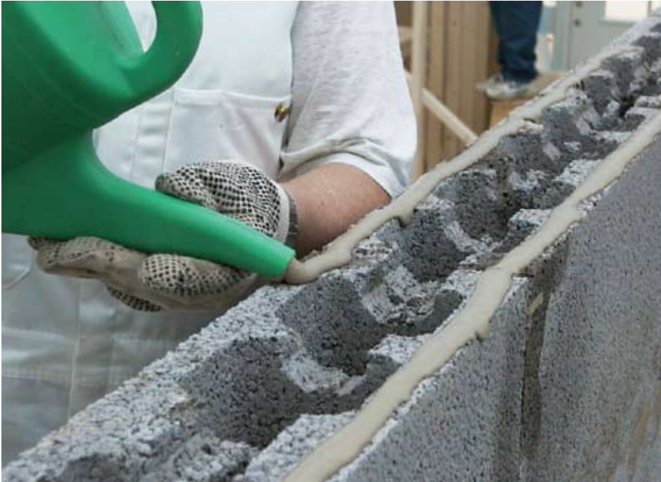
Kuva 2.14. Liimattava betoniharkko.
