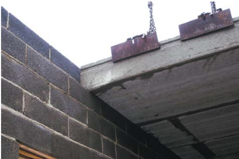
Kuva 4.32. Ontelolaatan asennus kevytsoraharkkoseinän päälle.
