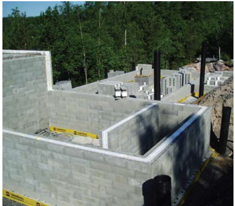
Kuva 4.15. Anturamuotin päälle ladottu kellarin valuharkkoseinä.
