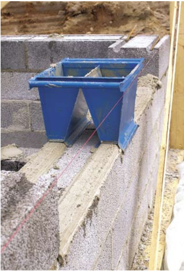
Kuva 4.12. Muurauskelkalla laastikerroksesta tulee tasainen.
