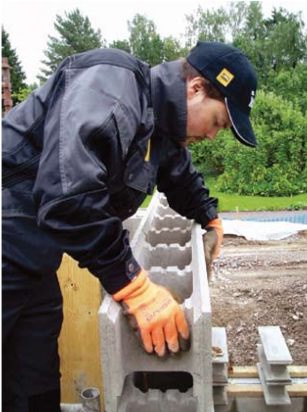
Kuva 2.11. Valettavien betoniharkkojen ladontaa. Vaakaraudoite asennetaan valuharkossa olevaan uraan.
