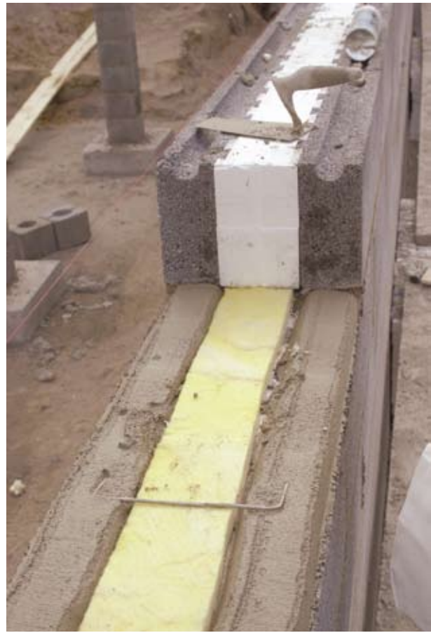
Kuva 4.13. Rakosaumaan on asennettu mineraalivillakaista ja muurausside.
