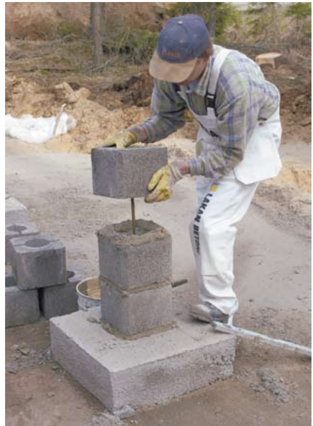
Kuva 4.17. Pilarin tekoa pilariharkoista. Harkon raudoitteet asennetaan onteloon ja ontelo valetaan betonilla.
