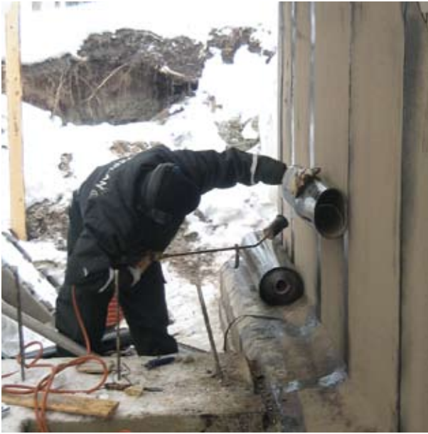
Kuva 4.20. Perusmuurin vedeneristystä bitumikermeillä.
