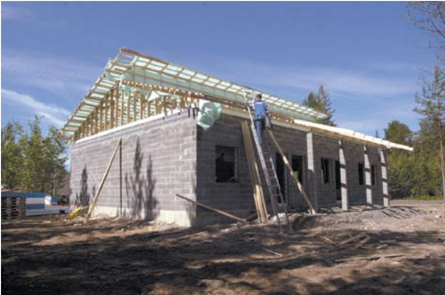
Kuva 4.33. Puurakenteinen yläpohja on yleinen harkkotaloissa.
