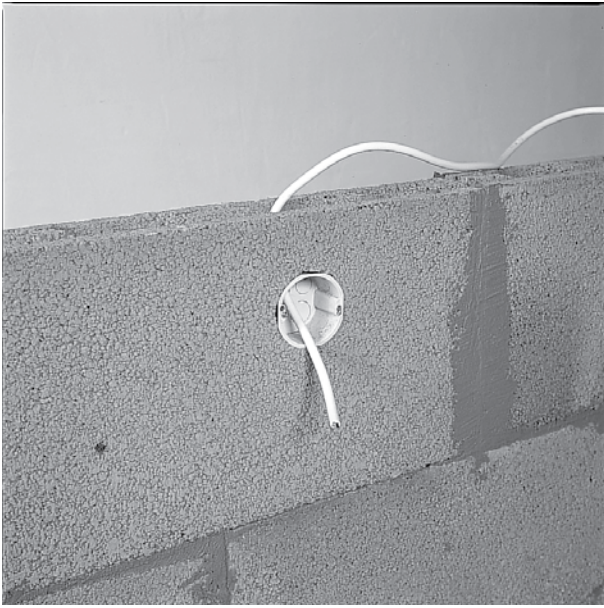
Kuva 4.37. Sähkörasian pohjan asennus väliseinääharkkoon.
