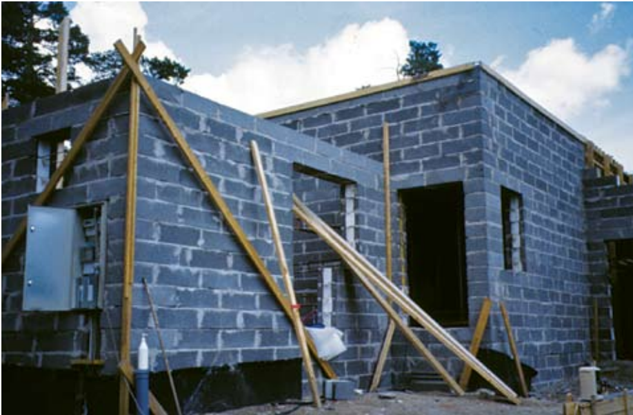
Kuva 4.25. Kevytsoraharkkotalo rakenteilla.
