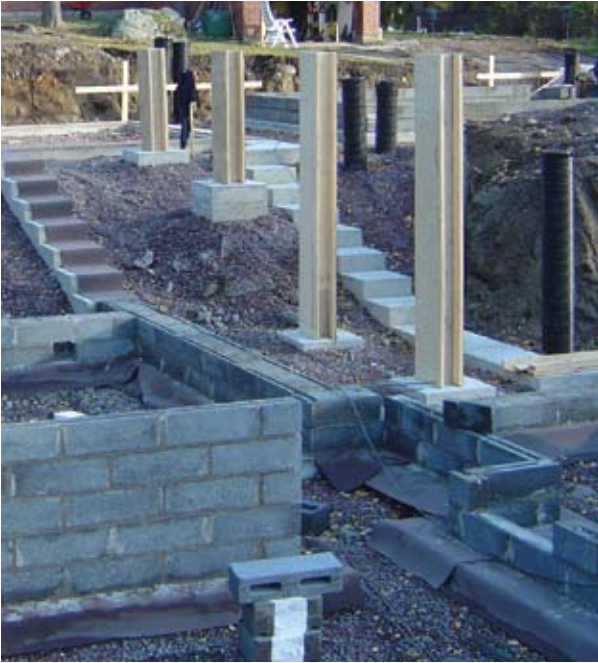
Kuva 4.9. Paikallavalettu ja porrastettu antura.
