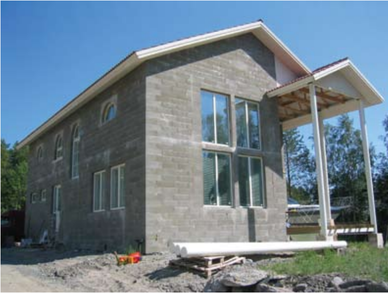
Kuva 2.10. Rakenteilla oleva betoniharkkotalo.
